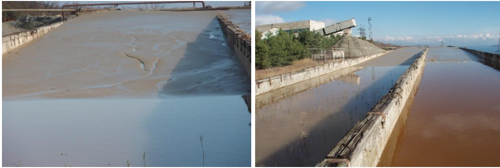
Рис. 1. Шламоотстойник Шархинского карьера объемом 5 тыс. м 3 Fig. 1. Sludge sump of the Sharkhinsky quarry with a volume of 5 thousand m 3
