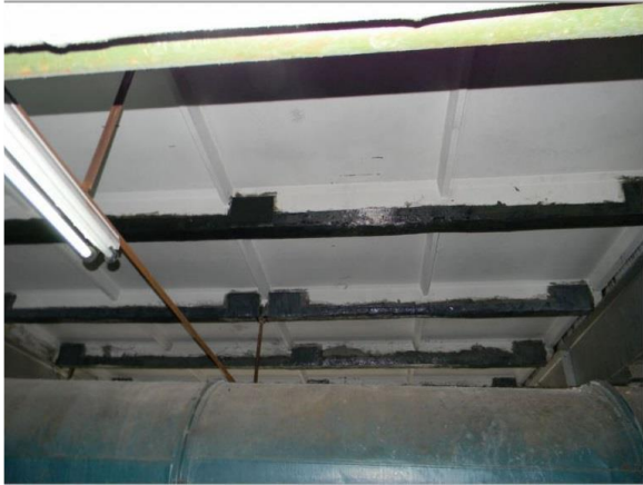
Рис. 1. Фотография армирования сборных ребристых плит композитными материалами Fig. 1. Photo of reinforcement of prefabricated ribbed slabs with composite materials
