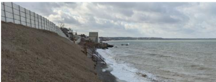
Рис. 3. Естественный клиф на месте разрушенных берегоукрепительных сооружений в районе пансионата «Радуга». Fig. 3. Natural cliff at the site of the destroyed bank protection structures in the area of the Raduga boarding house.
