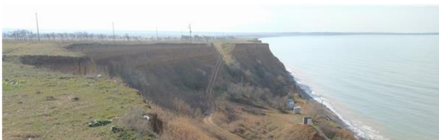
Рис. 2 Абразионно-оползневой берег южнее участка реконструкции Fig. 2. Abrasion-landslide coast to the south of the reconstruction
