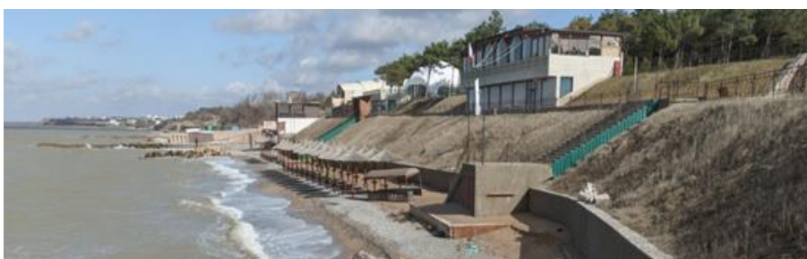
Рис. 9. Берегоукрепительные сооружения в районе ООО «Мар Ле Мар», ООО «Чембало». Fig. 9. Bank protection structures in the area of Mar Le Mar LLC, Chembalo LLC.
