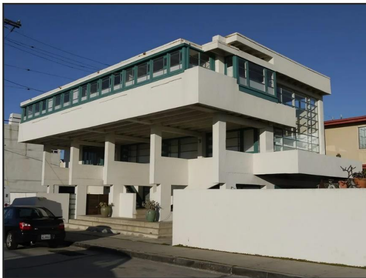
Рис. 8. пляжный дом Лоувелла, архитектор Рудольф Шиндлер Fig. 8. Lowell's Beach House, architect Rudolf Schindler
