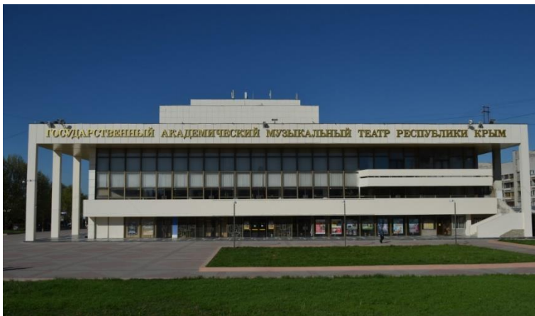
Рис. 4. Музыкальный театр в г. Симферополе, архитекторы: В. Юдин, С. Амзаметдинова
